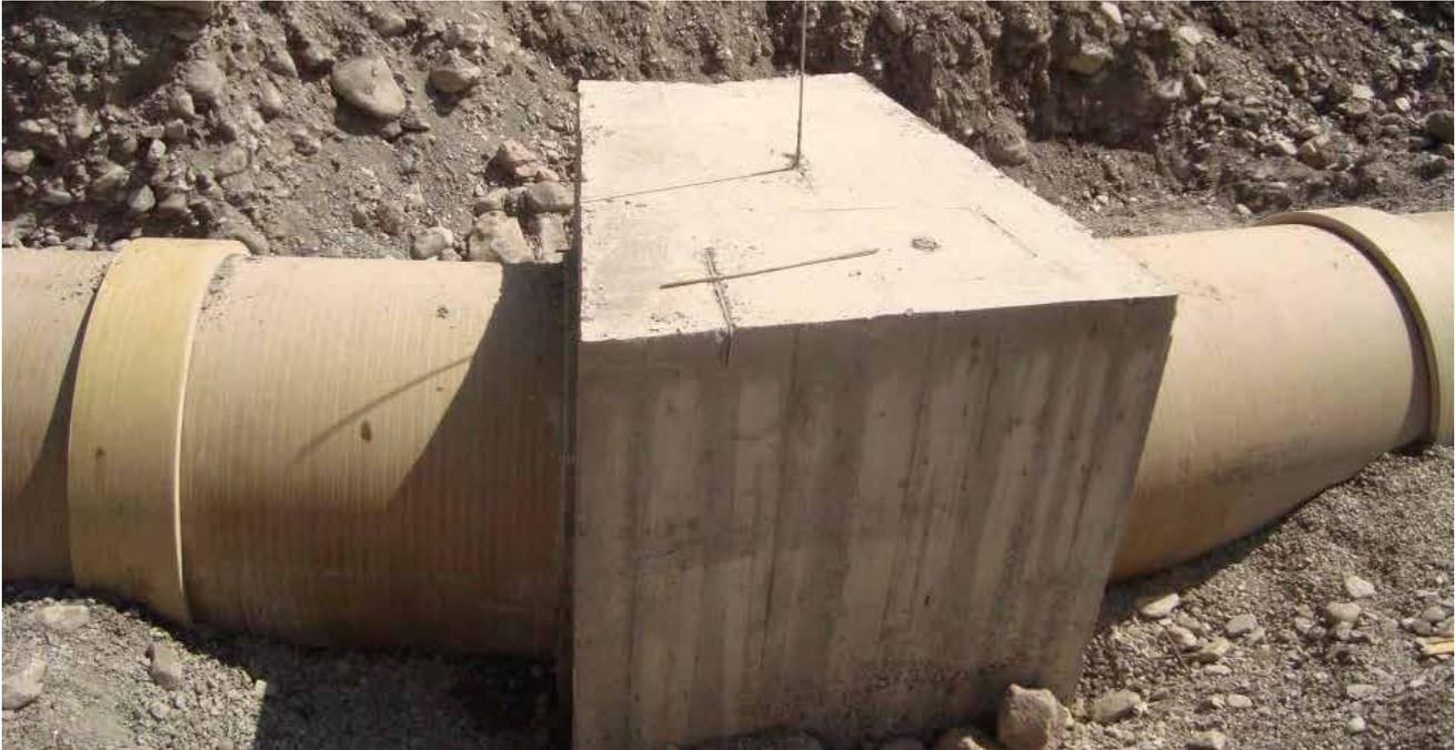
HINWEIS: Biaxiale Rohre und Formstücke sind die beste Lösung für Projekte, in denen der Bau von Beton Drucklagern nicht gewünscht oder möglich ist. Bei solchen Rohrleitungen bestehen Kupplungen und Formstücke aus längskraftschlüssigen Verbindern wie Stoßlaminatverbindern, Scherstab-Verbindern oder Flanschen.
