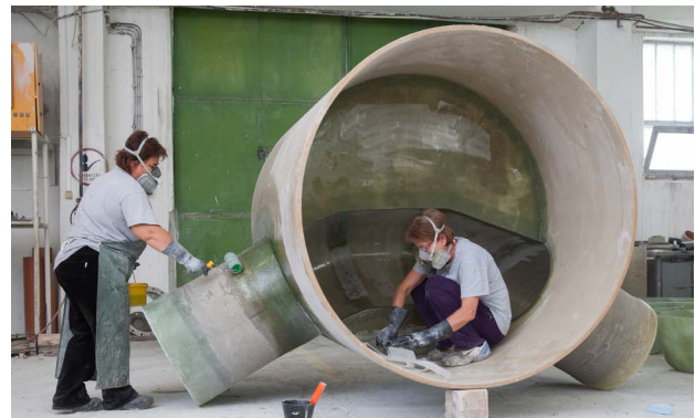
Herstellung eines Schachtbauwerkes
