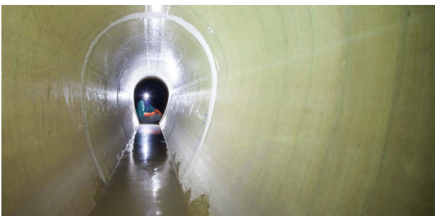
Relining mit GFK-Eiprofilen
